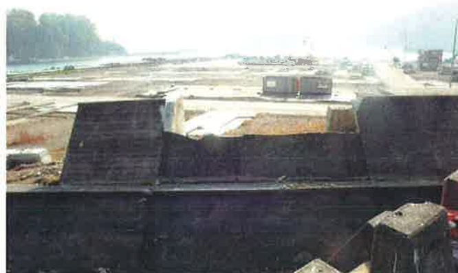
農林省事業の防潮堤。津波には持ちこたえられなかった
